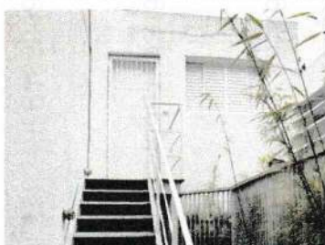
Acesso externo para o 2º andar
