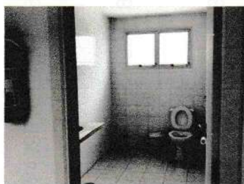
Banheiro 2º andar
