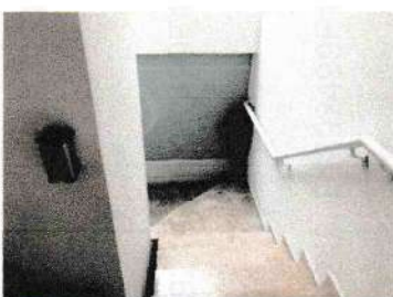
Escada de acesso para o 2º andar
