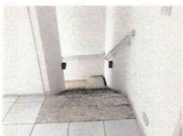
Escada de acesso para o 2º andar
